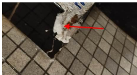
Ouvrage : 3 - Parois verticales intérieures - Revêtements de murs, poteaux, cloisons, gaines, coffres Partie : Colle/plinthe Description : Colle/plinthe Localisation : IME - Rez-de-chaussée - Pièce 17 Présence amiante
