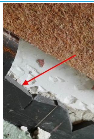
Ouvrage : 3 - Parois verticales intérieures - Revêtements de murs, poteaux, cloisons, gaines, coffres Partie : Colle/plinthe Description : Colle/plinthe Localisation : IME - Rez-de-chaussée - Pièce 36 Présence amiante
