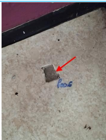
Ouvrage : 5 - Planchers et planchers techniques - Revêtements de sols Partie : Revêtement plastique/colle Description : Revêtement plastique/colle Localisation : IME - Rez-de-chaussée - Pièce 2 Présence amiante
