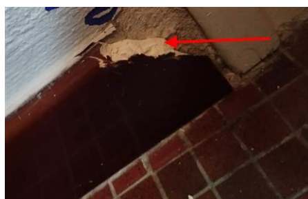
Ouvrage : 3 - Parois verticales intérieures - Revêtements de murs, poteaux, cloisons, gaines, coffres Partie : Colle/plinthe Description : Colle/plinthe Localisation : IME - 1 er étage - Pièce 64 Présence amiante
