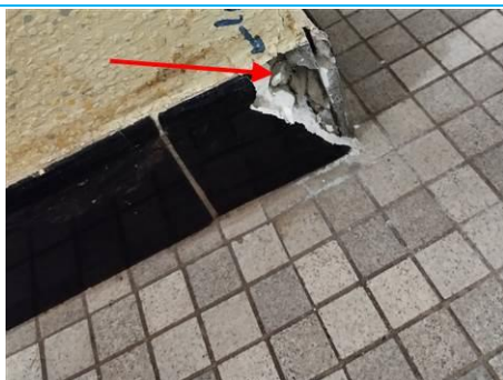
Ouvrage : 3 - Parois verticales intérieures - Revêtements de murs, poteaux, cloisons, gaines, coffres Partie : Colle/plinthe Description : Colle/plinthe Localisation : IME - 1 er étage - Pièce 41 Présence amiante
