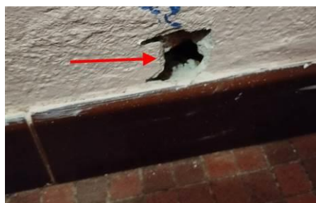
Matériaux : ZPSO-060 Prélèvement : P060 Description : Peinture décorative/revêtement gris Localisation : IME - Rez-de-chaussée - Pièce 67 Résultat : Présence d'amiante
