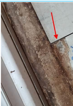
Ouvrage : 5 - Planchers et planchers techniques - Revêtements de sols Partie : Dalle de sol/colle Description : Dalle de sol/colle Localisation : IME - Rez-de-chaussée - Pièce 22 Présence amiante
